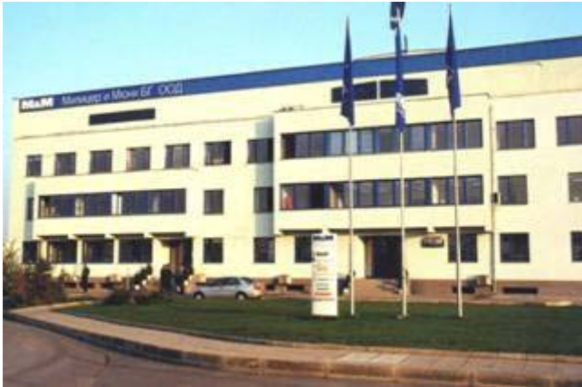
M&M Terminal Sofia, Foto: Kulke-Fiedler
